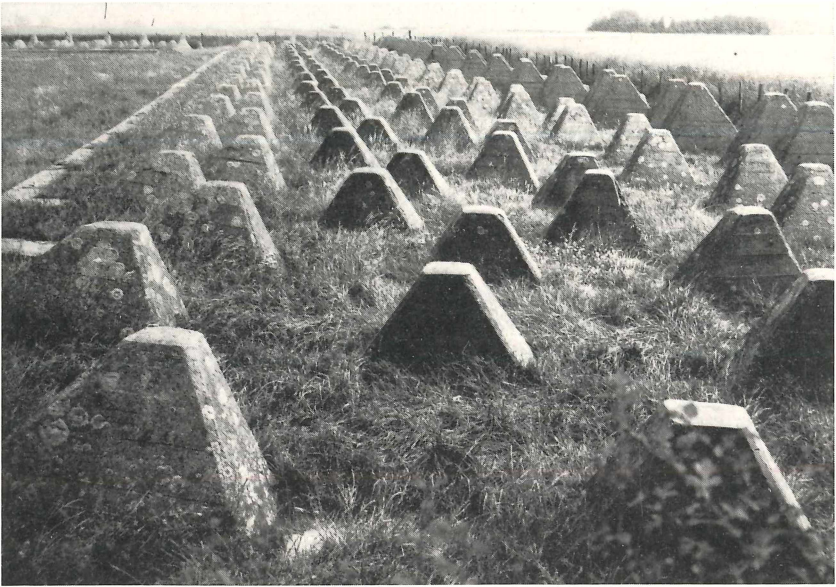
Abb. 1: Übersichtsfoto vom Panzersperren-Gürtel zwischen Vetschau und Horbach. Die Strukturträger mit dem Mauerrand (links) und der hohen Höckerreihe (rechts) werden durch die Weidenutzung gut erkennbar (August 1986).
